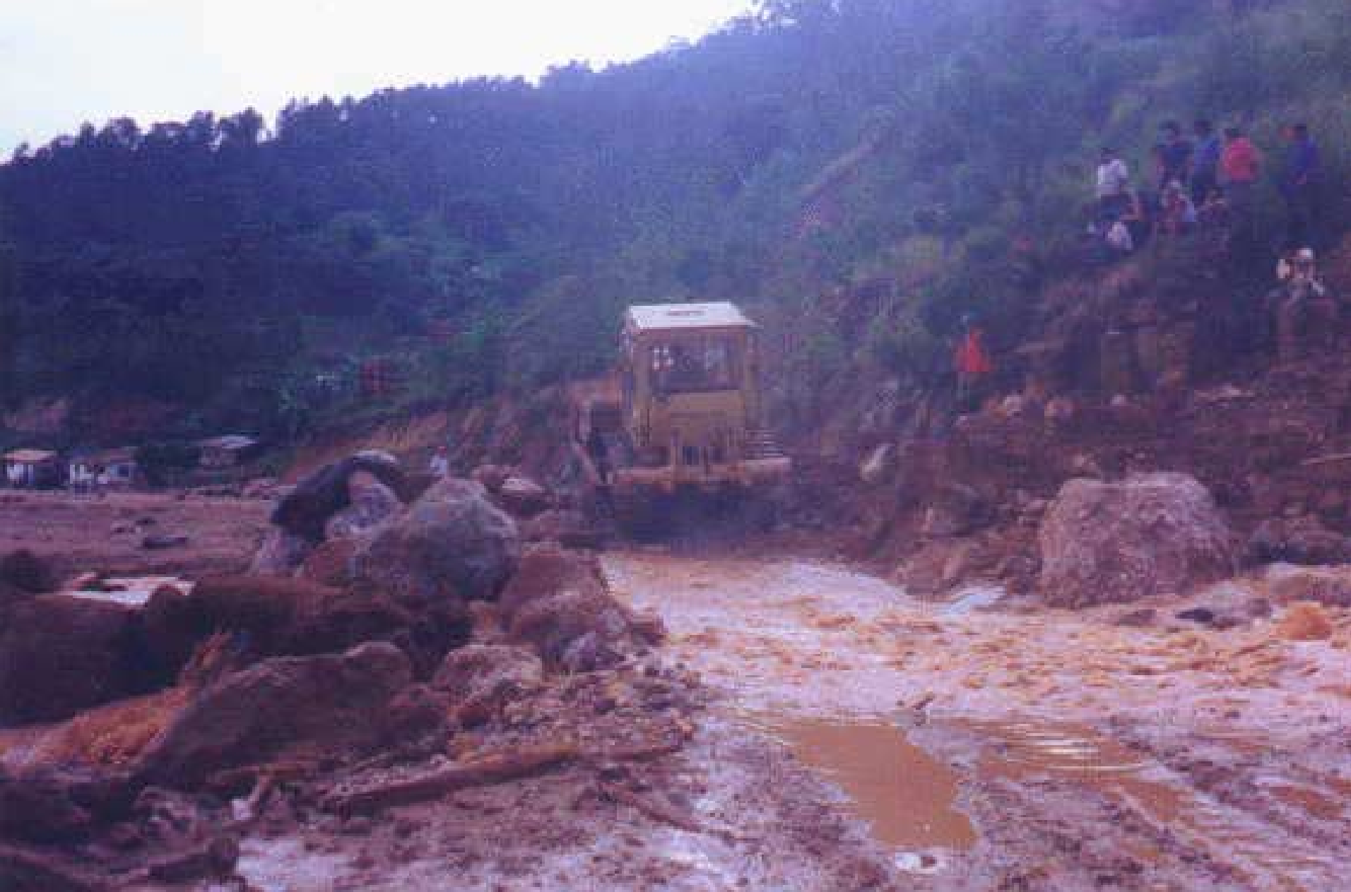
CONDICIONES VIAS POST MITCH TRACTOR REMOVIENDO ROCAS QUE OBSTRUYERON EL TRANSITO VEHICULAR ESTACION: 21+070 TRAMO: TEGUCIGALPA - DANLI
